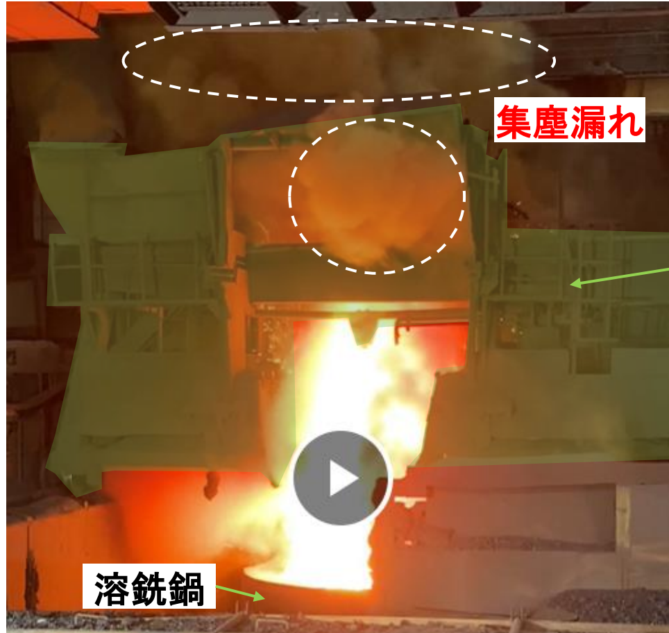
【溶銑払出時の様子(東から)】
